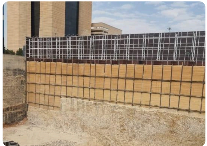
تدعيم جوانب حفر عميق بجوار أبراج قائمة، الرياض
