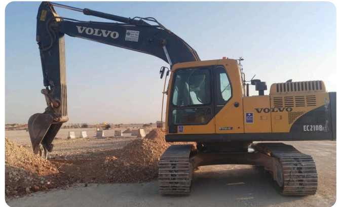
حفارة فولفو EC210B أثناء أعمال الحفر
