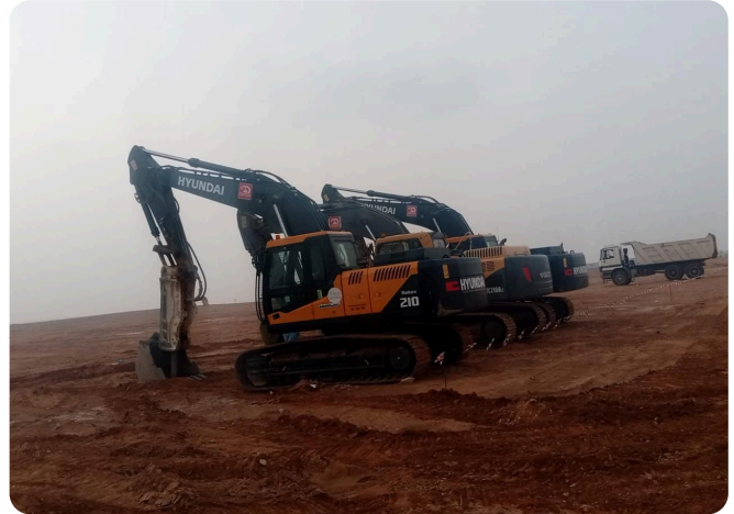
أعمال حفر وتسوية وترحيل ناتج الحفر
